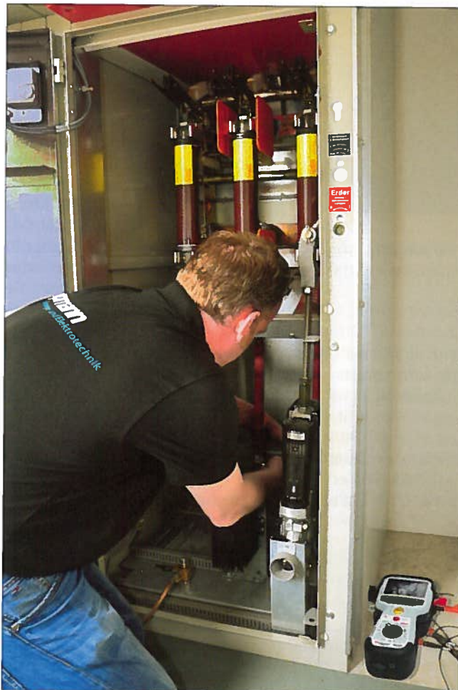
Bild 4: Der Einsatz des Niederohmmessgerätes MOM 2 wird vorbereitet
